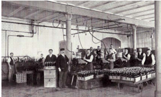
Abfüllen der Flaschen mit Schläuchen um 1890
